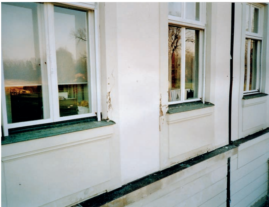
Die verschmutzte Fassade mit stellenweise abblättrender Farbe wurde neu gestrichen.
