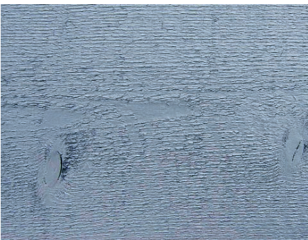
Eine Fassade mit unbehandeltem Holz vergraut ungleichmässig, was optisch viel störender ist als die Vergrauung an sich.
