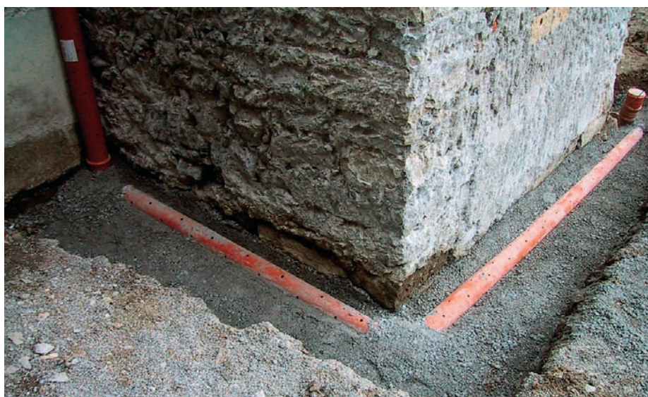
Im Fundamentbereich wurden Sickerleitungen eingebaut, die das Oberflächenwasser vom Mauerwerk fernhalten. (Foto: Wickli + Partner)
