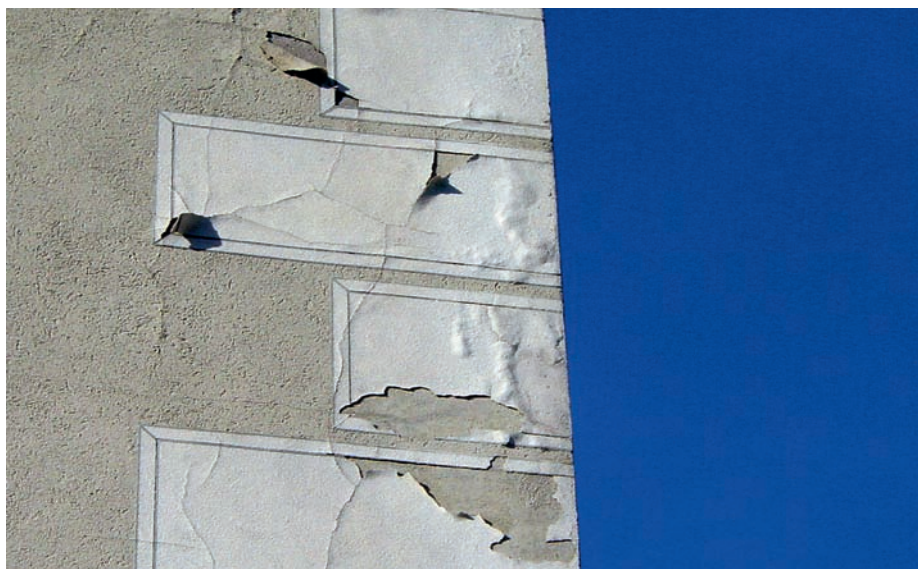
Die aufgemalten Ecklisenen lösten sich grossflächig ab.
