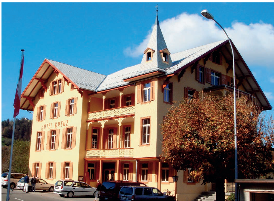
Im Sommer 2006 wurde das Hotel Kreuz im luzernischen Romoos mit reinen Ölfarben gestrichen. Der Untergrund war altes Holz, das unterschiedlich stark ausgewittert war und Reste alter Ölfarbenanstriche aufwies. Teilweise wurde auch neues Holz gestrichen.
