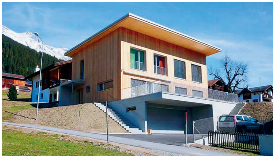
Moderna casa unifamiliare con impregnante protettivo per lignina e trattamento superficiale idrorepellente.
