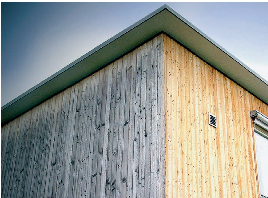
Una facciata con legno non trattato ingrigisce in modo non uniforme, con effetto ottico molto più sgradevole rispetto all'ingrigimento in sé.
