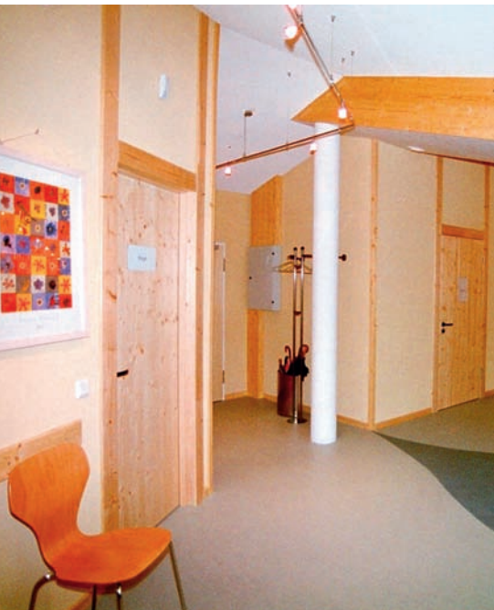
4 Alle Oberflächen des Ärztehauses in Waldbröl sind mit farbigem oder weissem Lehm verputzt und mit einer Lehmfarbe gestrichen. (Foto: Architekturbüro Pahl-Kaupp)
