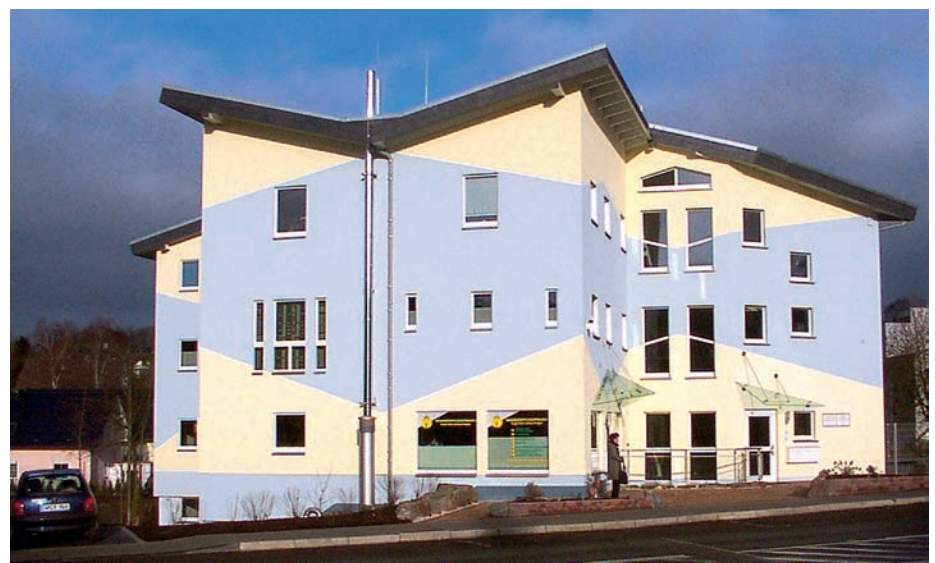
3 Im nachhaltig gebauten Ärztehaus im deutschen Waldbröl stärkt die Architektur die Gesundheit und das Wohlbefinden der Patienten. Die Innenwände sind aus 10 cm starken Leichtlehm-Platten errichtet, die sowohl Feuchtigkeit und Wärme speichern als auch Schall dämmen. (Foto: Architekturbüro Pahl-Kaupp, DE-Waldbröl)
