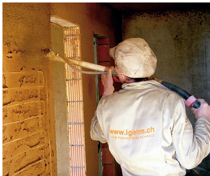
Ein Lehmgrundputz lässt sich problemlos auch maschinell auftragen.
