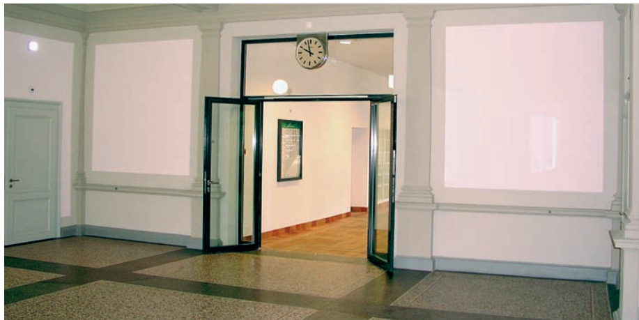
Die Wand links neben der Durchgangstür musste nach dem Abbruch von Regalen massgenau zur Wand rechts wiederhergestellt werden.
