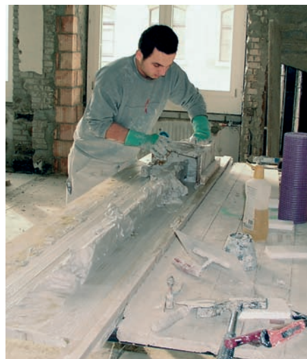
Lehrling Sead Mulolli beim Ziehen von Profilen.
