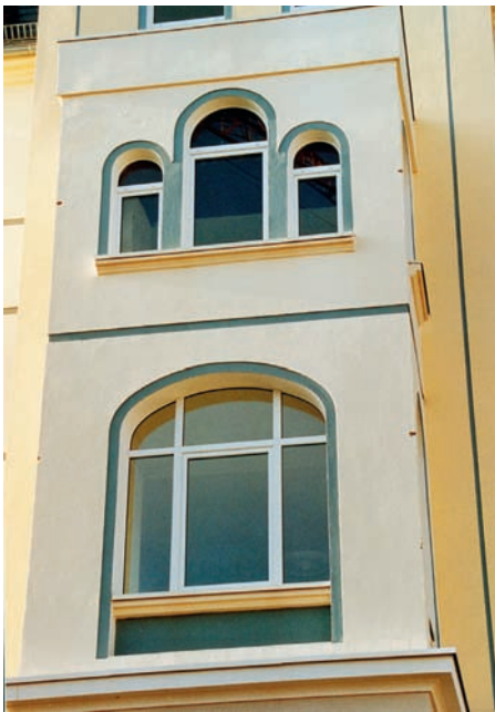
Fenstergestaltung mit Silikonharzfarben bei einem Wohnhaus in Gera (Thüringen, Deutschland).
