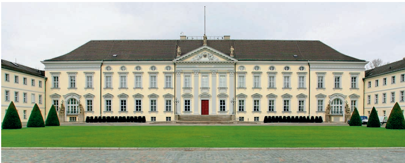
Mit Silikonharzfarben gestrichen werden können auch denkmalgeschützte Bauten wie das Schloss Bellevue in Berlin.
