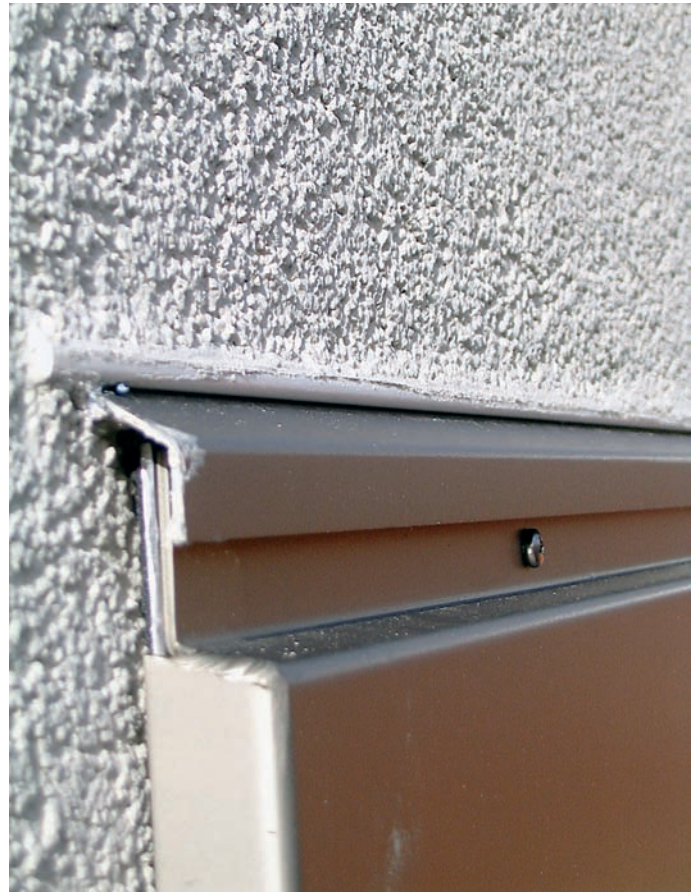
Erfolgreiche Sanierung der Fensterkonstruktion mit Hilfe eines Überstülpkastens und durch Anwendung eines Blechanschlussprofils aus Kunststoff (im Bild oben, eingeputzt).
