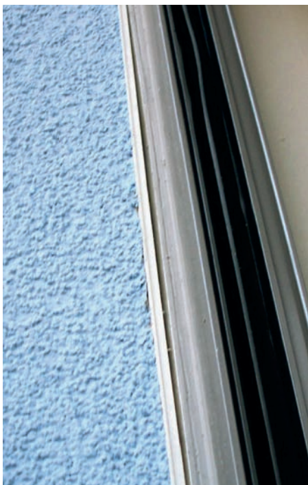
Werden Gewebeleisten ohne Teleskop-Eigenschaft eingesetzt, können sich bei grossen Längen die Profile wie hier ablösen.
