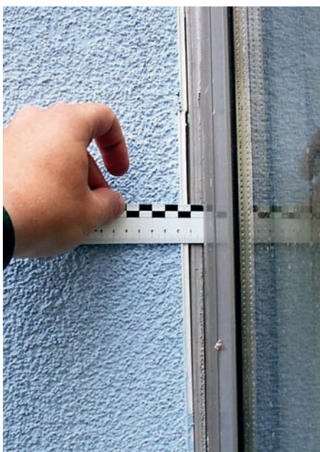
Gewebeleisten ohne Teleskop-Eigenschaft: Profilablösung im Stumpfstoss.
