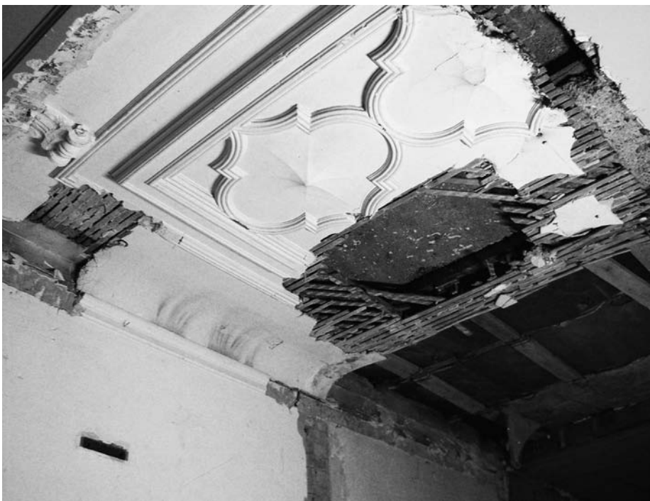
Knifflige Arbeit: Diese stark lädierte Stuckdecke musste restauriert werden.
