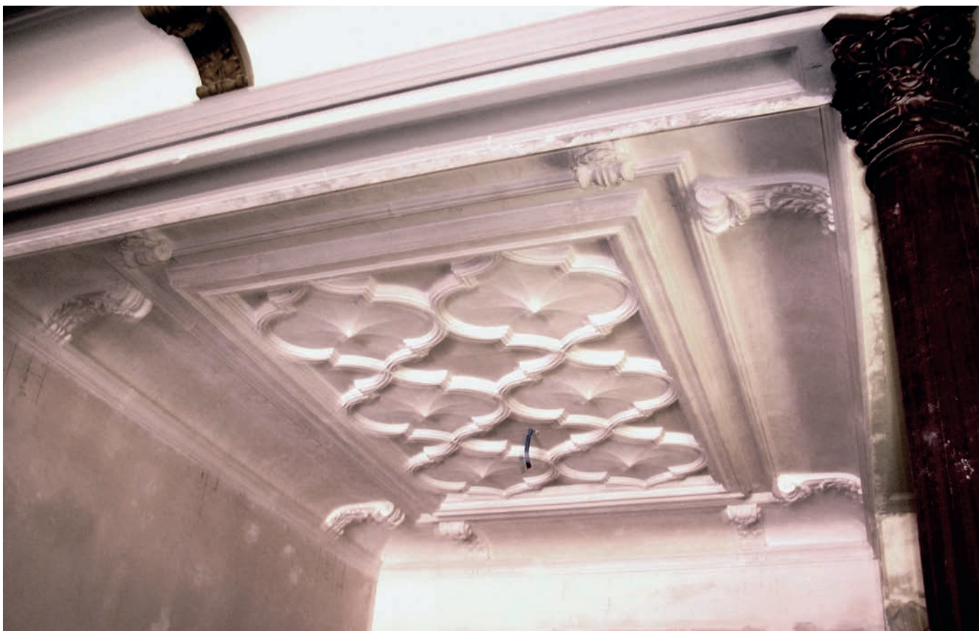
Fertig: Die restaurierte Decke im Eingangsbereich.
