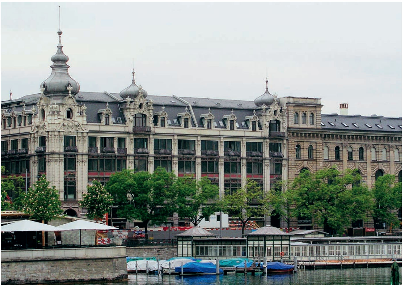
Das historische Metropol-Gebäude neben der Fraumünsterpost in Zürich wurde stilgerecht umgebaut und renoviert.
