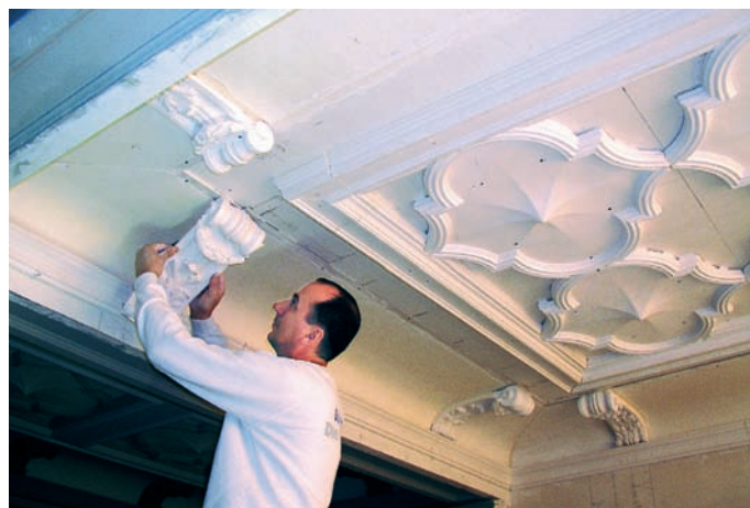
Bajram Kashtanjevatc bringt die Konsolen an. Gut zu erkennen sind die Schraubenlöcher für zusätzliche Befestigungen von Deckenelementen und Konsolen.
