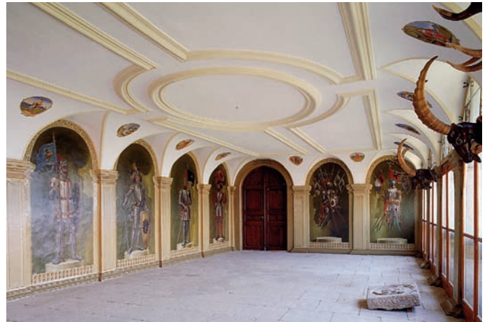
Nachher: Rechts die erneuerten Geweihe in der Eingangshalle, links die Ritterbilder mit der ursprünglichen Architekturmalerei. (Foto: Kantonale Denkmalpflege Aargau, Christine Seiler)
