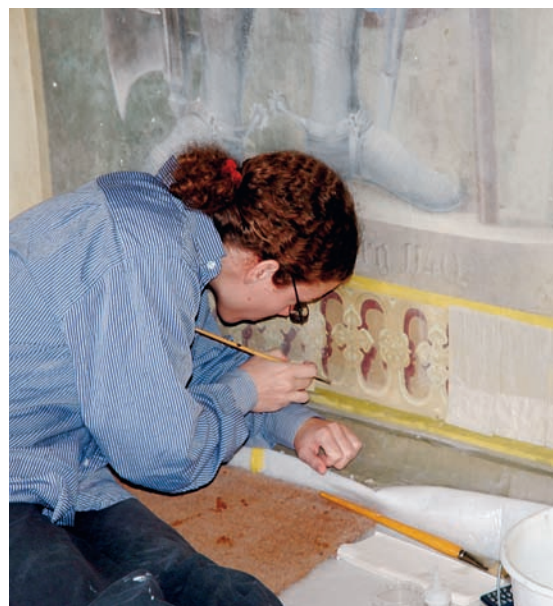
Eine Restauratorin beim Ergänzen der ursprünglichen Architekturmalerie in der Eingangshalle. (Foto: Castor Huser)
