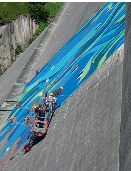
Arbeiten an der geeigneten Staumauer: Die freiwilligen Helfer mussten schwindelfrei sein.
