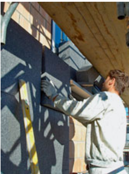
2 Die erhöhte Eigenspannung von nicht weissen expandierten Polystyrolplatten (EPS) kann bei fehlender Beschattung dazu führen, dass sich die Platten zu schüsseln und sich bei noch nicht erhärteter Klebeverbindung vom Untergrund selbstständig wieder abzulösen beginnen.
