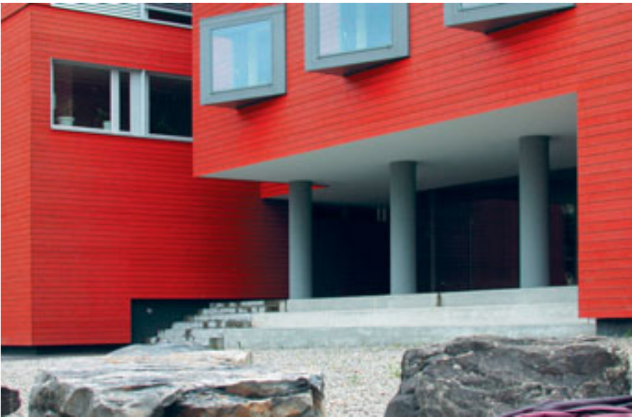
Detail des Studentenwohnhauses in Immensee: Die hinterlüftete, mit sägeroher Fichte geschaltete Holzfassade wurde farblos tiefenimprägniert und mit einer Dreifach-Holzlasur pigmentiert. Der Bau wurde 2002 mit dem «prix pentol» ausgezeichnet. (Bild: Pentol/Lignum)
