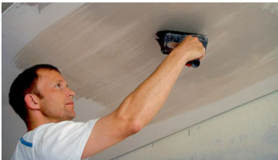
Zur Prüfung der Saugfähigkeit empfiehlt der SMGV, die Benetzungsprobe mit der Plafondbürste auf einer Fläche von mindestens 1 m 2 zu machen. (Bild: SMGV)
