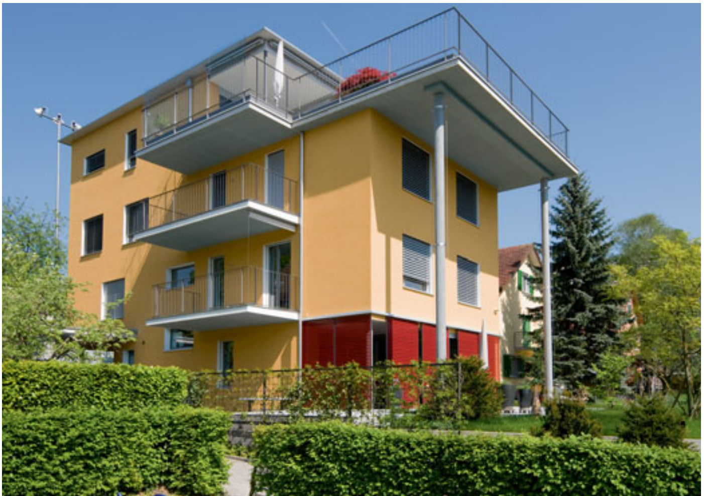
Eine biozidfreie, verputzte Aussenwärmedämmung bedeutet nachhaltige Fassadengestaltung – ob bei einer Sanierung oder bei diesem Neubau mit 200 mm EPS-Dämmung. (Bild: Greutol)
