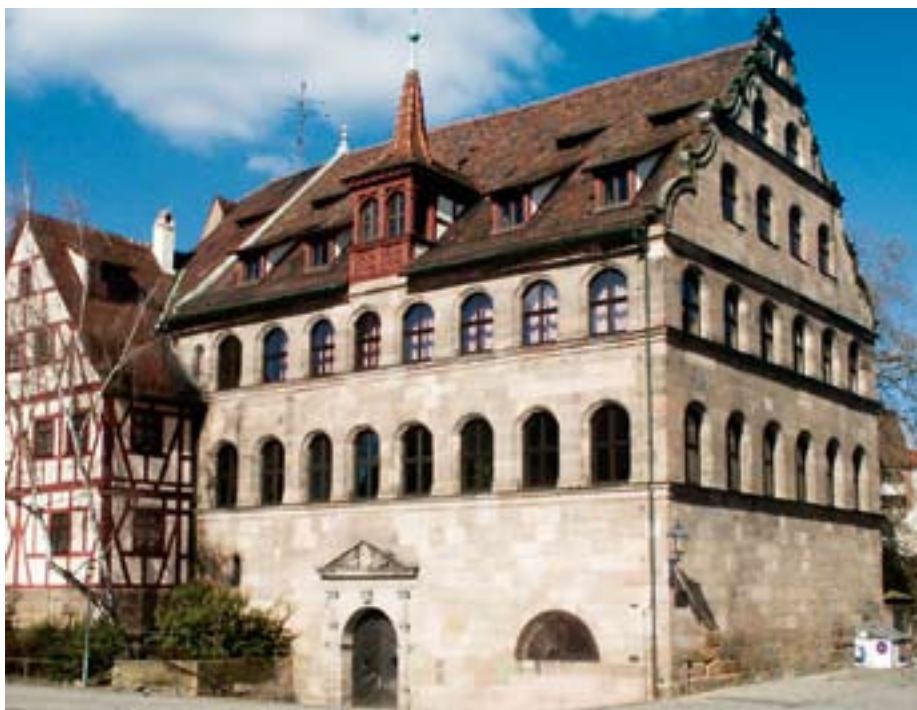
Das denkmalgeschützte Herrenschiesshaus mit Renaissance-Sandsteinfassade in Nürnberg wurde 1582 erbaut. Zwei Räume wurden 2001 innen gedämmt.
