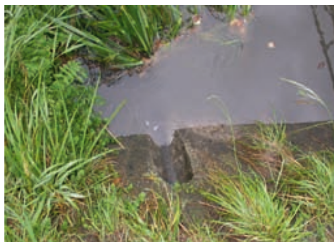
Einleitung des Oberflächenabflusses in den Chimlibach, über die Fassaden und Parkplätze entwässert werden. Im Wasser wurden Aggregate und Einzelpartikel der \text{TiO}_2 -Weisspigmente nachgewiesen.
