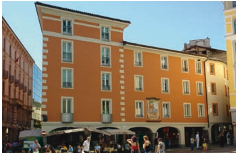
Die Farbtöne «Salmone Arancio» und «Grigio Gronda» des Beschichtungssystems Dolwasil von Dold bringen südliches Ambiente auf diese Fassade in Lugano. (Bild: Dold)
