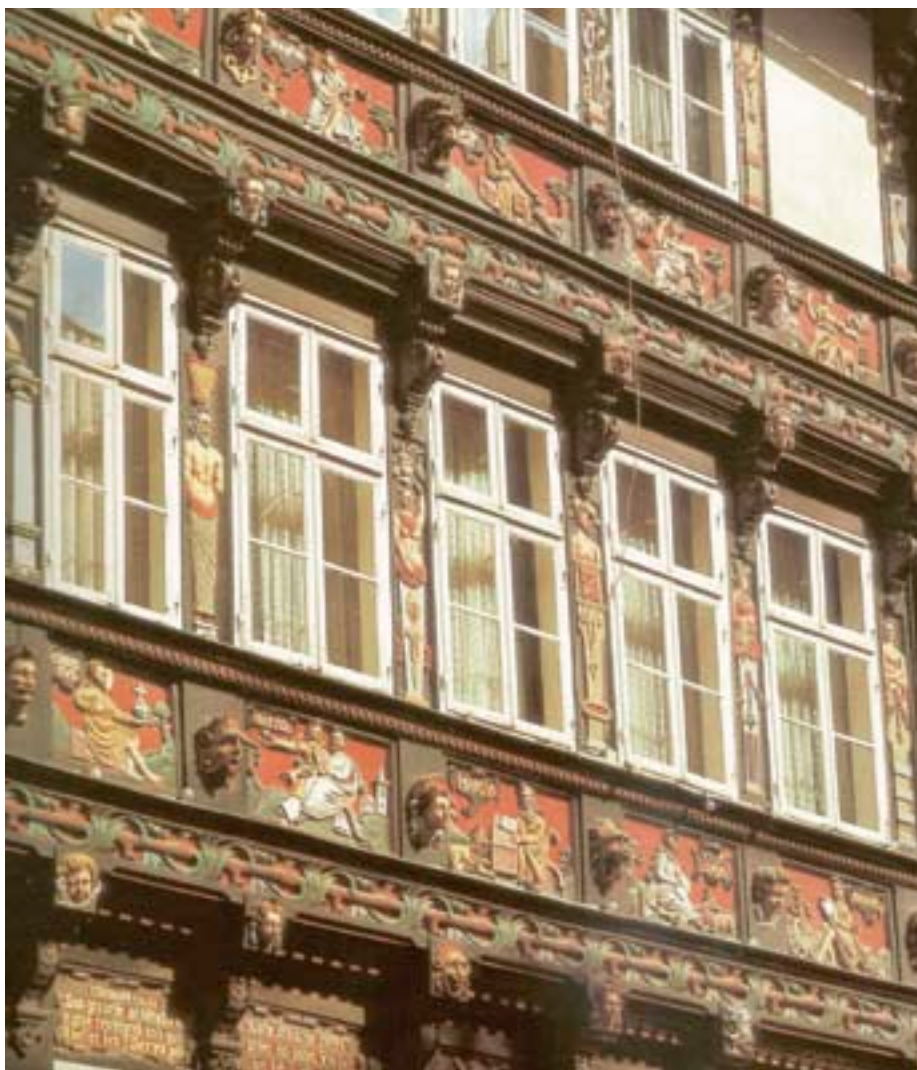
Mit Holzschnitzereien verzierte und farbig gefasste Aussenfassade eines deutschen Renaissance-Bürgerhauses von 1610 in Einbeck. Zum Einsatz kamen hier Öl- und Kaseinfarben. (Quelle: Gatz, Konrad. Ein Jahrtausend Maler und Lackierer. Kulturgeschichte eines Handwerks. Deutsche Verlagsanstalt. Stuttgart 1994. Abbildung S. 117 – Bildarchiv Seeger.)
