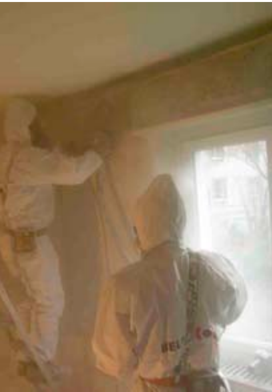
Sanierungsarbeiten mit grosser Staubentwicklung und hoher Exposition. (Bild: Belfor Suisse)
