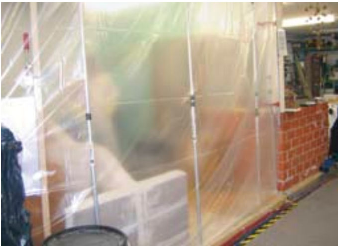
Schwarz-Weiss-Trennung durch Abgrenzung mit Plastikfolie. (Bild: Belfor Suisse)
