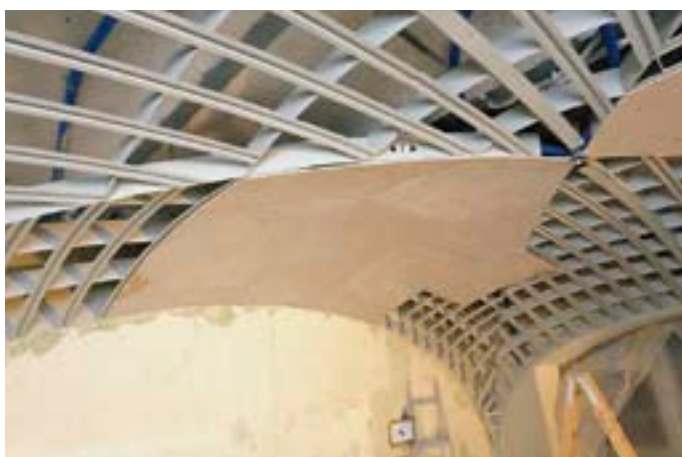
2-lagige Beplankung mit 6,5 Millimeter dicken Gipsplatten.
