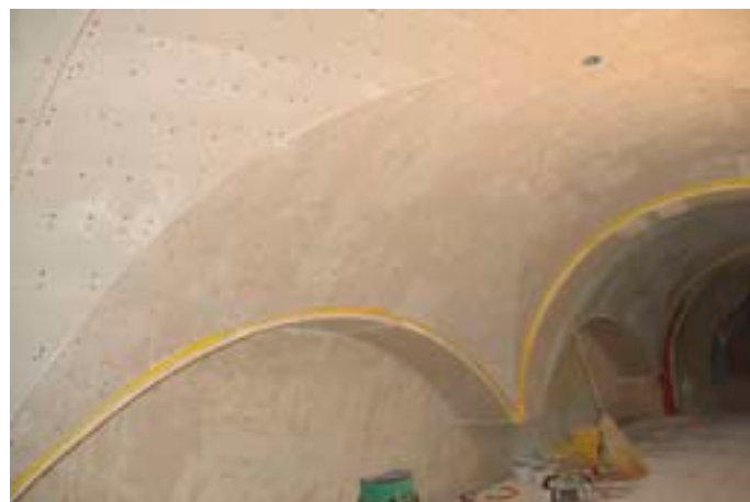
Das Kreuzgewölbe ist bereit zur vollflächigen Abglättung.
