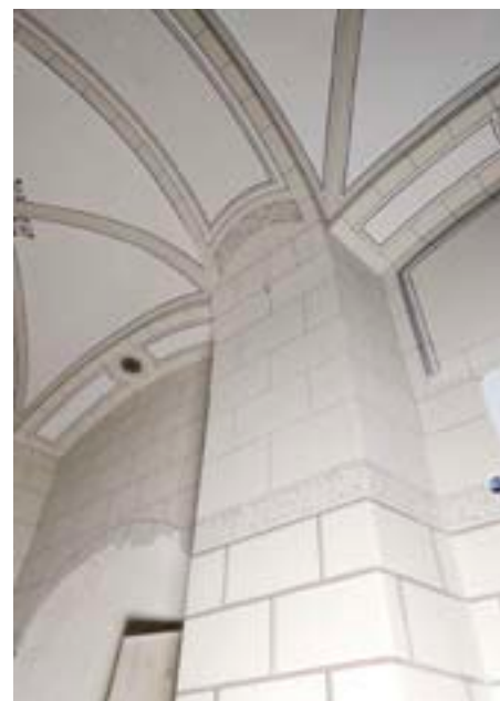
Die Beschichtung der Gewölbe betont ihre Form.
