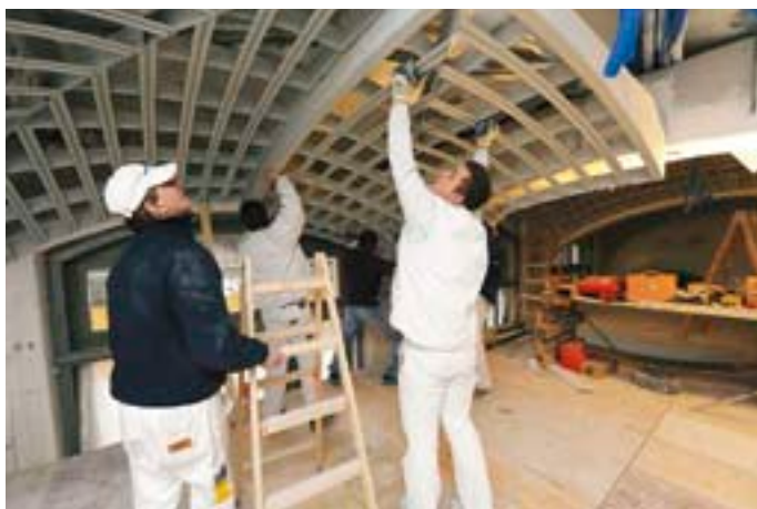
Massarbeit: Einpassen der Unterkonstruktion in die Dachbalken.
