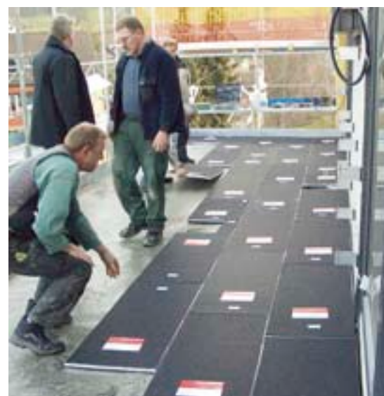
Vakuum-Dämmplatten werden seit Jahren erfolgreich bei der energieeffizienten und gleichzeitig dünn-schichtigen Terrassenisolation eingesetzt. (Bild: ZZWancor AG)
