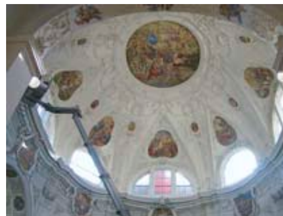
Blick in das Oktogonkuppelgewölbe der Klosterkirche Muri. Von einer Hebebühne aus (links im Bild) wurde der Zustand der Malereien abgeklärt.
