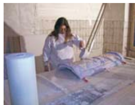
Die beschädigten Stuckelemente mussten geflickt werden, damit später saubere Abgüsse davon gemacht werden konnten.
