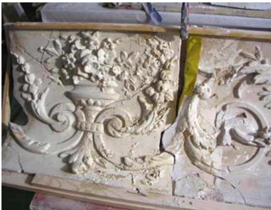
Die beschädigten Stuckelemente mussten geflickt werden, damit später saubere Abgüsse davon gemacht werden konnten.
