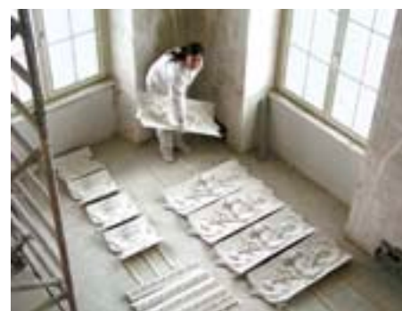
Arbeitsablauf beim Herstellen der Stuckhohlkehlen: Mit dreizehn Trichtern wird Silikon in eine konkave Form gegossen, um eine Formvorlage zu erhalten. Mit dieser macht die Malerin Petra Effinger Gipsabgüsse, die danach – hier zusammen mit ebenfalls abgegossenen Lorbeer- und Eierstabprofilen – zum Trocknen ausgelegt werden müssen (Bilder von oben).
