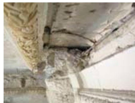
Eine abenteuerlich anmutende Unterkonstruktion von damals: Rundeisen und Rabitz.
