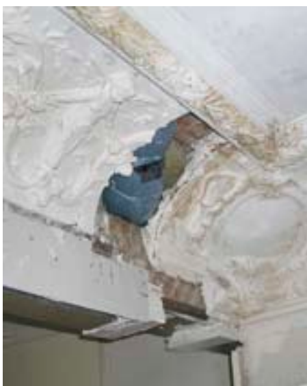
Eine Knacknuss, die es zu lösen galt: Das dick blau ummantelte Rohr passte nicht unter die neuen Stuckhohlkehlen, deshalb musste ein Teilstück speziell bearbeitet werden.
