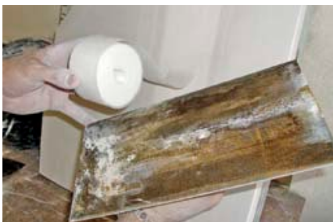
Beim Einarbeiten des Glasvlies-Bewehrungsstreifens darf an der Traufel kein Material sein.
