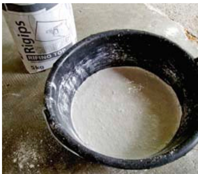
Den Gips drei bis vier Minuten sumpfen lassen.
