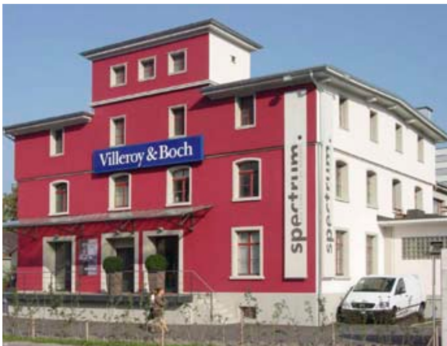
Gebäude von Villeroy & Boch in Lenzburg: Die roten Flächen wurden mit Exposan Top, die weissen Flächen mit Exposit-Silicon-Mineralfarbe von Bosshard ausgeführt.
