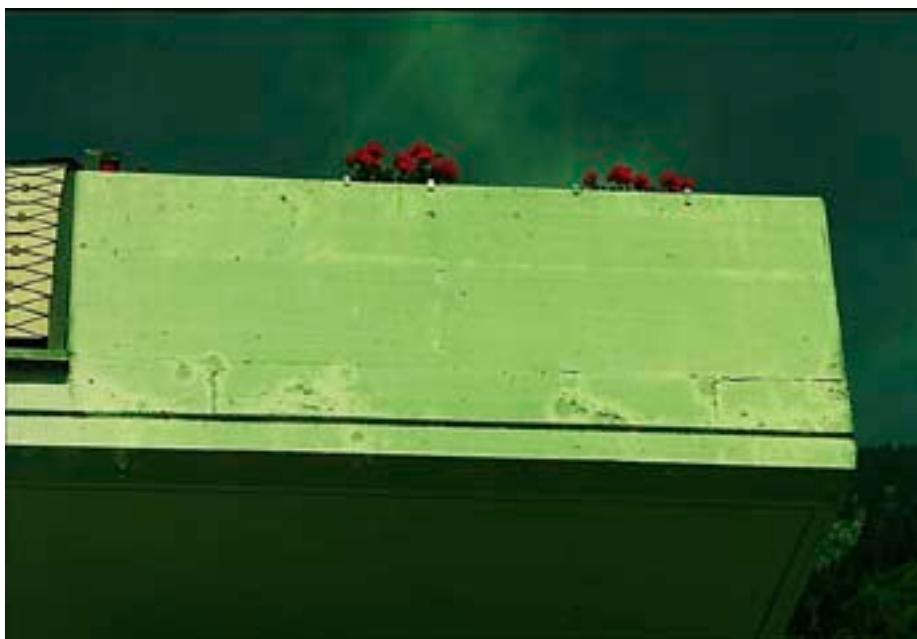
Diese Ausblühungen sind entstanden, weil zu früh überstrichen wurde.
