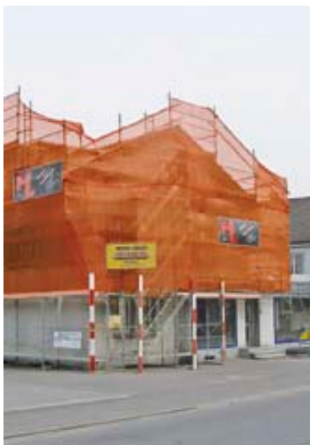
Vorbildlich installiertes Gerüst in Roggwil BE.
