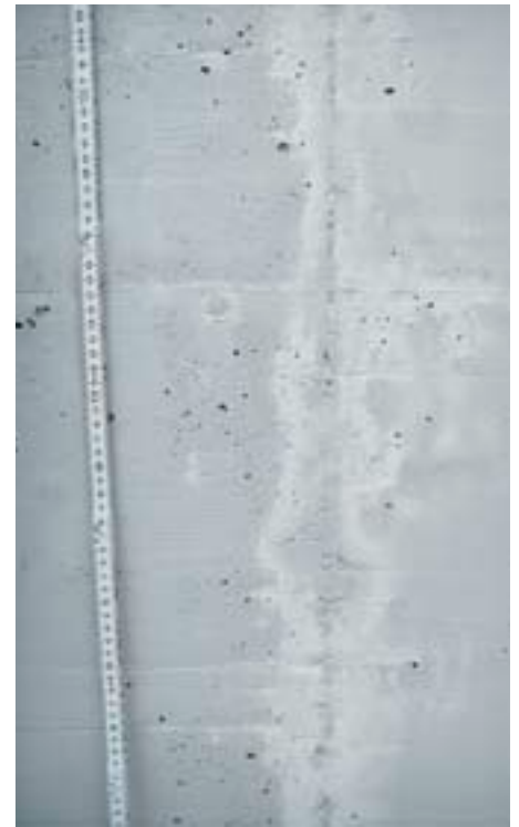
Ces changements de couleur ont été causés par l'application prématurée du revêtement. (Photos: Walter Schläpfer)
