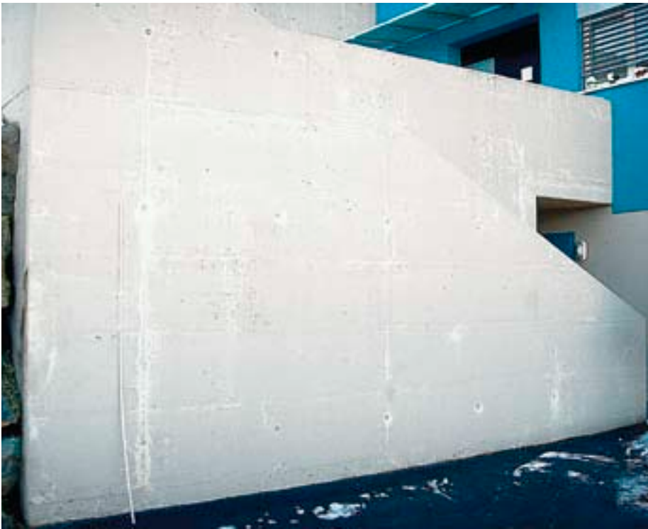
Ces changements de couleur ont été causés par l'application prématurée du revêtement. (Photos: Walter Schläpfer)
