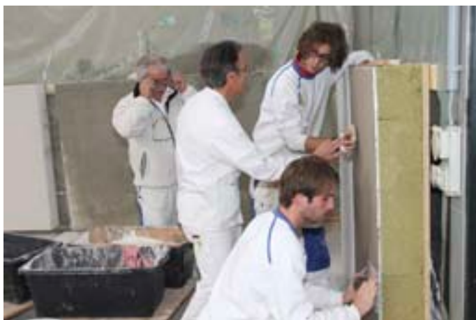
Wie muss der Edelputzkratzer geführt werden, damit eine schöne Struktur dabei herauschaut?
