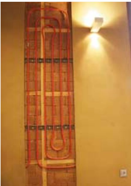
Im Untergeschoss öffnet sich die Lehmoberfläche und gewährt einen Einblick in Wandheizung und Stapelwände. (7)
