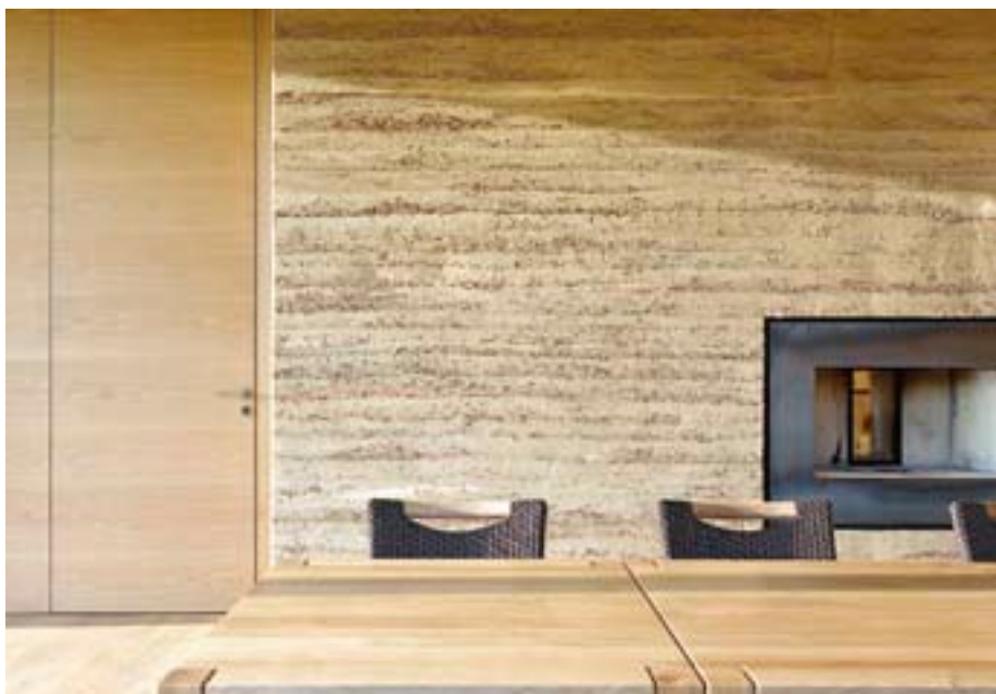
Beruhigend wirken die mineralisch geschichtete Stampflehmwand und der in sie integrierte offene Kamin. (2)
