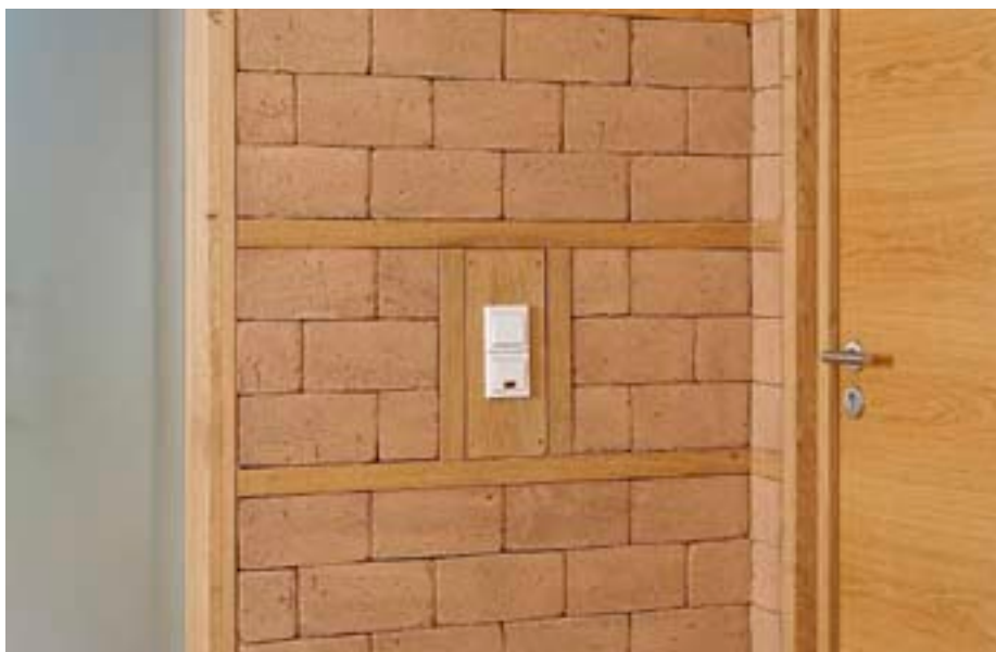
Besonders bei Tageslicht wirken die Lehmsteine wie eine Trockenmauer, rhythmisiert durch Eichenleisten. (9)
