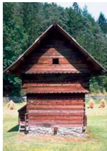
Blockbau mit sukzessiven Auskragungen zum Schutz des Bauwerkes. (Bild: Ronacher)
