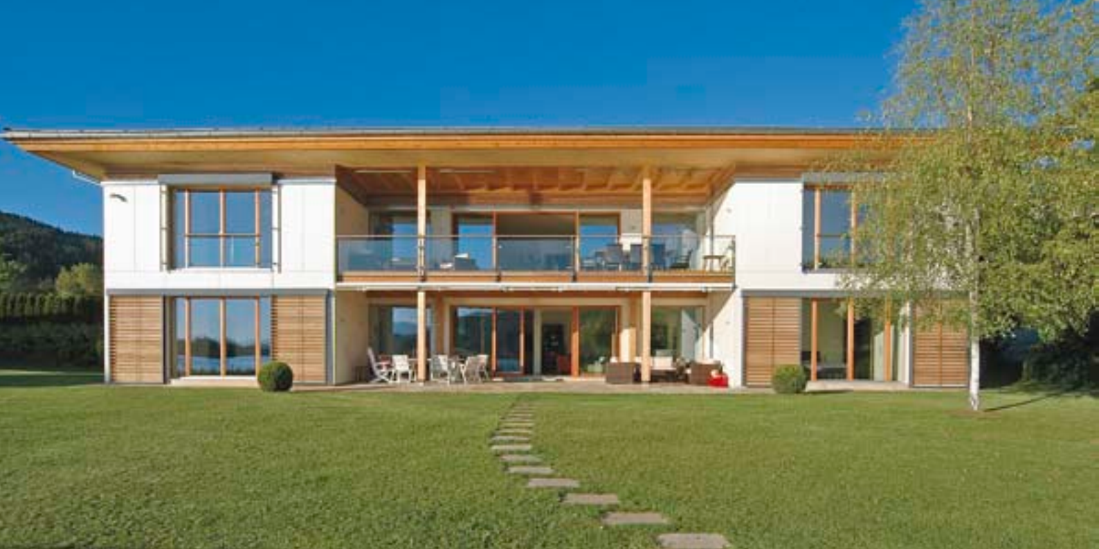
Gut geschützter Bau: Wohnhaus am Wörthersee, Kärnten. (Bild: Ronacher)
