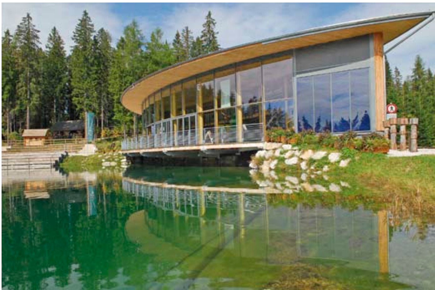
Geringe Chancen für Algen- und Pilzbefall dank des weit ausladenden Daches: «Arche des Waldes» im österreichischen Mariazell. (Bild: ÖBF)
