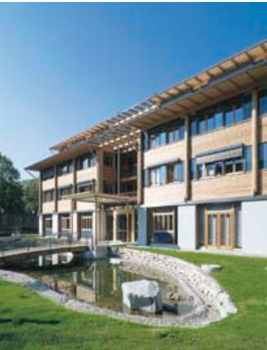
Weit ausladendes Vordach in zwei Geschossen als konstruktiver Bautenschutz: Bürogebäude der Österreichischen Bundesforste AG, Niederösterreich. (Bild: ÖBF)
