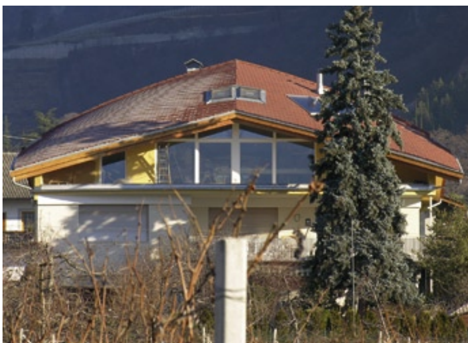
Das alte Dach des 60er-Jahre-Baus wurde durch eine leicht geschwungene Konstruktion ersetzt.
