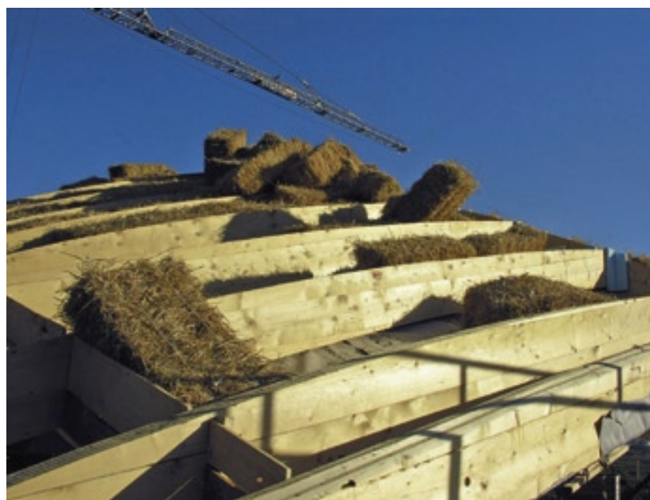
Strohballen vom Bauer dämmen Dach und Wände der Aufstockung.
