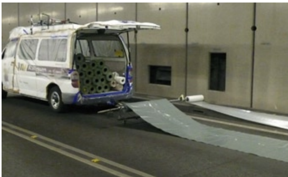
Der Folien-Abrollapparat wurde eigens für die Arbeit im Tunnel von Arnold Wyssen entwickelt.
