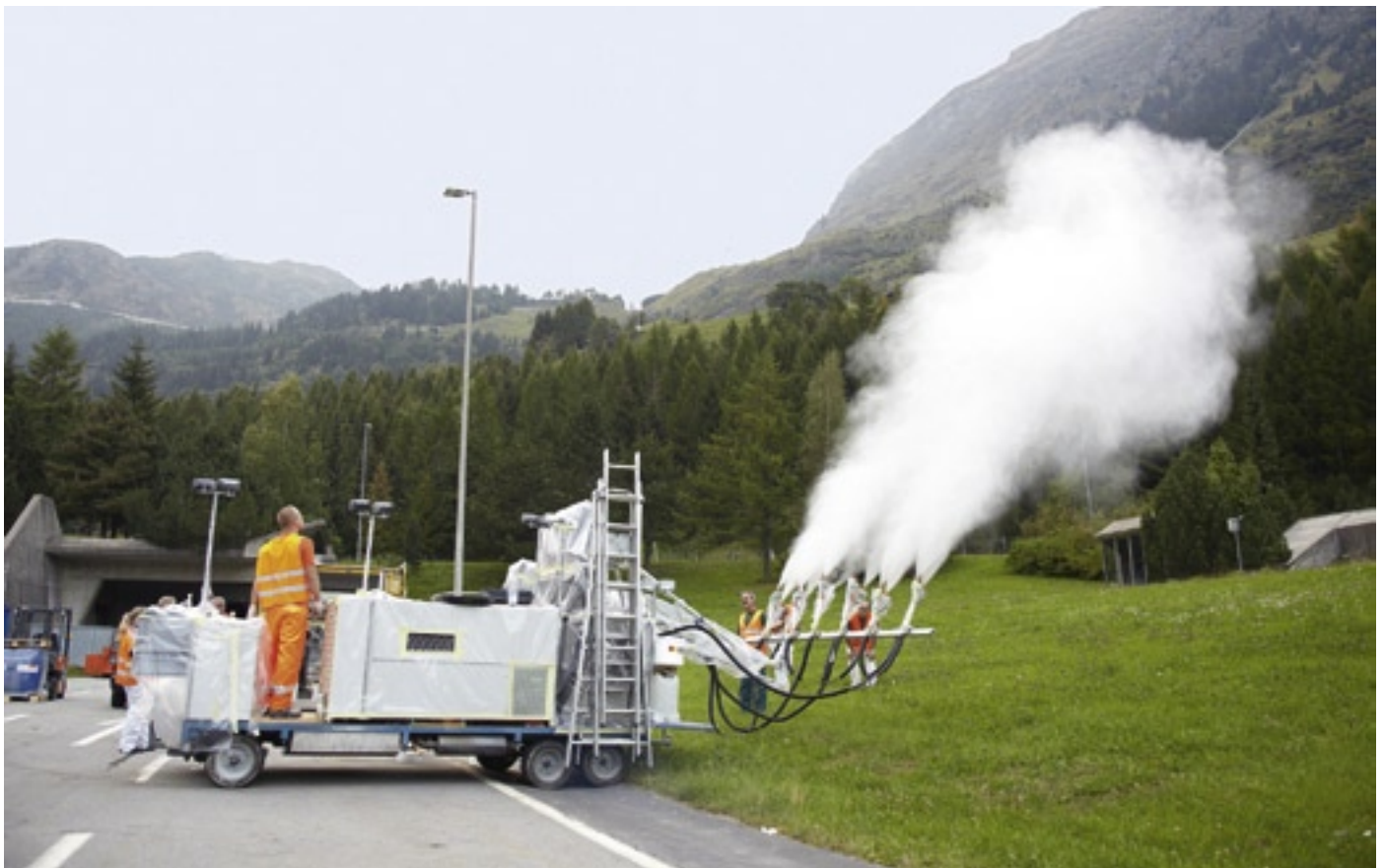
Hightech: Die letzten Tests mit dem Spritzgerät von Novaplica, bevor es im Tunnel losgeht. (Bild: Wacker)
