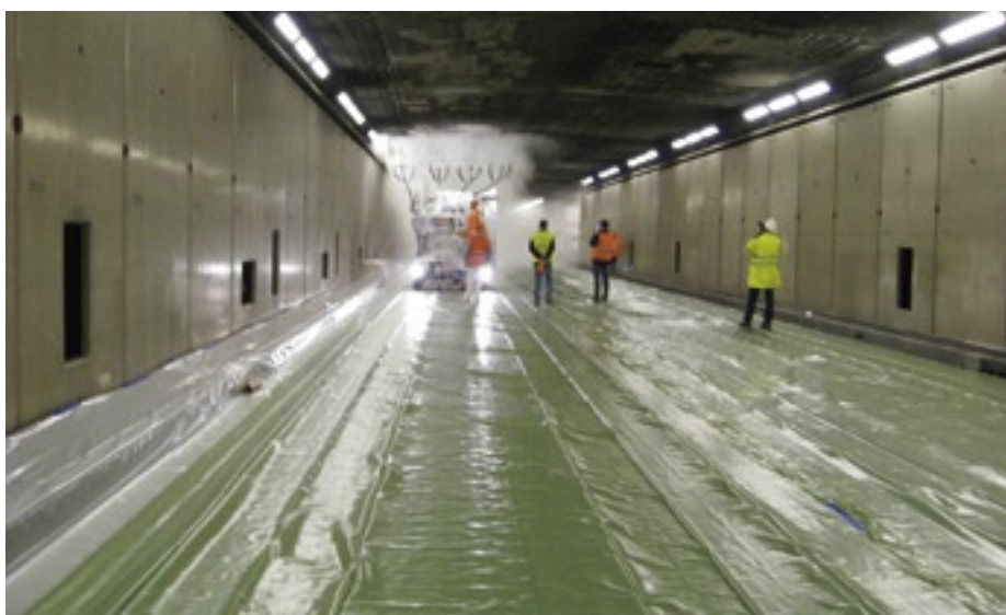
Unter Hochdruck wird die Silancreme an die Tunneldecke appliziert. (Bild: Novaplica)
