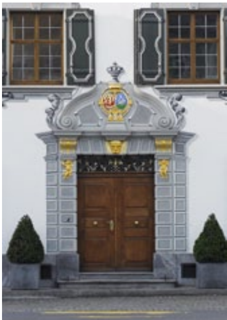
Über dem Hauptportal des Wetterhauses ist heute noch das Allianzwappen Wetter-Kunz des Bauherrn zu sehen.
