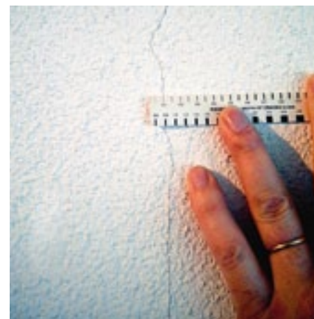
Abbildung 7: Auf MDF-Platten aufgeklebte Gipsplatten können Rissbildungen entlang dem Plattenformat der Gipsplatten zur Folge haben.
