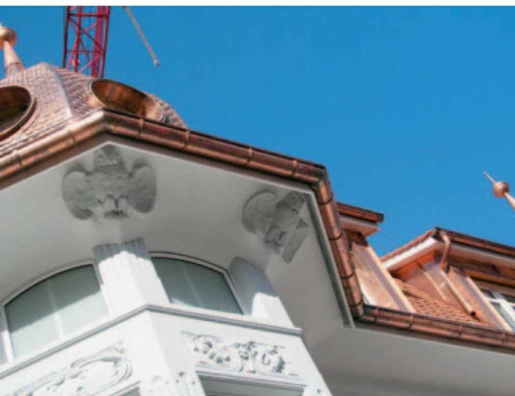
Die restaurierten Uhus an der Untersicht des neuen Kupferdachs: Es lohnt sich, beim Jugendstilhaus an der Bolleystrasse in Zürich nach oben zu schauen.
