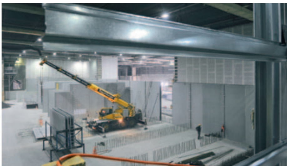
Feuerschutzplatten schliessen den Raum zwischen der Betonmauer und der Hallendecke.
