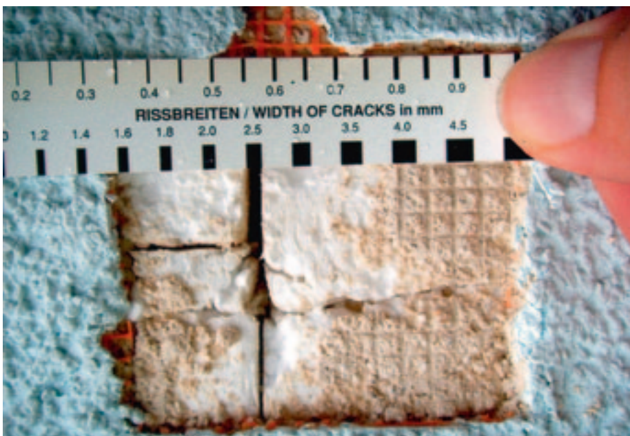
Offene Plattenfugen >1,5 mm Breite müssen sauber geschlossen werden.
