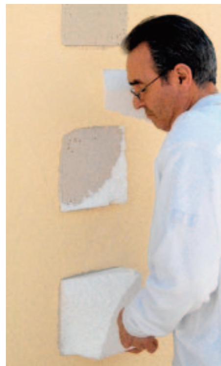
Zur Prüfung der Haftung auf dem bestehenden VAWD-Aufbau wird eine Abriss-Probemittel mittels einer aufgeklebten Dämmstoffprobe vorgenommen.
