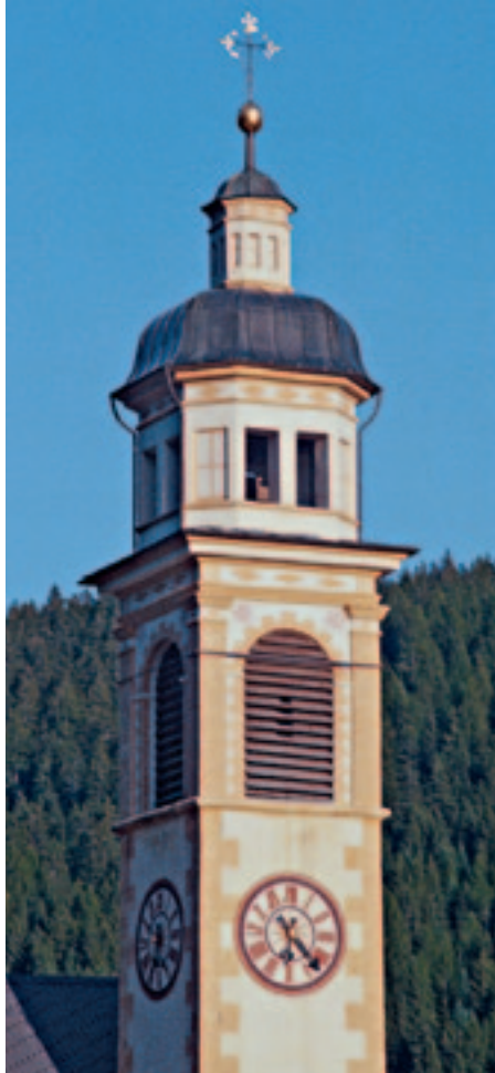
Seit 1667 strahlt der Kirchturm in Obervaz-Zorten in Gelb und Rot.
