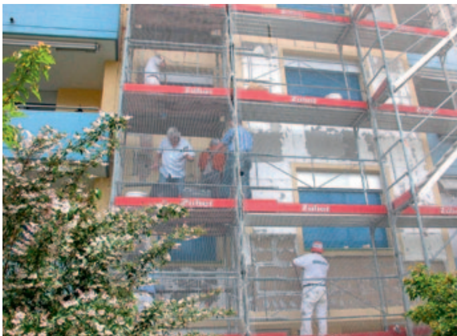
Bei allen vier Fassadensanierungen fallen verhältnismässig hohe Kosten für Gerüste und spätere Umgebungsarbeiten an.
