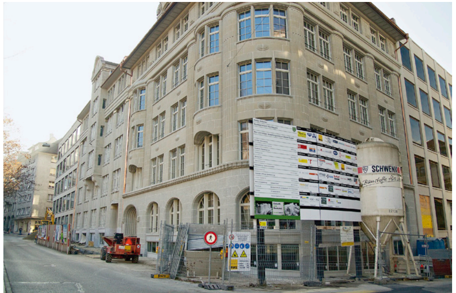
Beim Neubau (ganz rechts und links im Bild) des Verwaltungsgebäudes des Sicherheits- und Justizdepartements in St. Gallen arbeiteten polnische Gipser zu Tieflohnen. (Bild: Kursiv)
