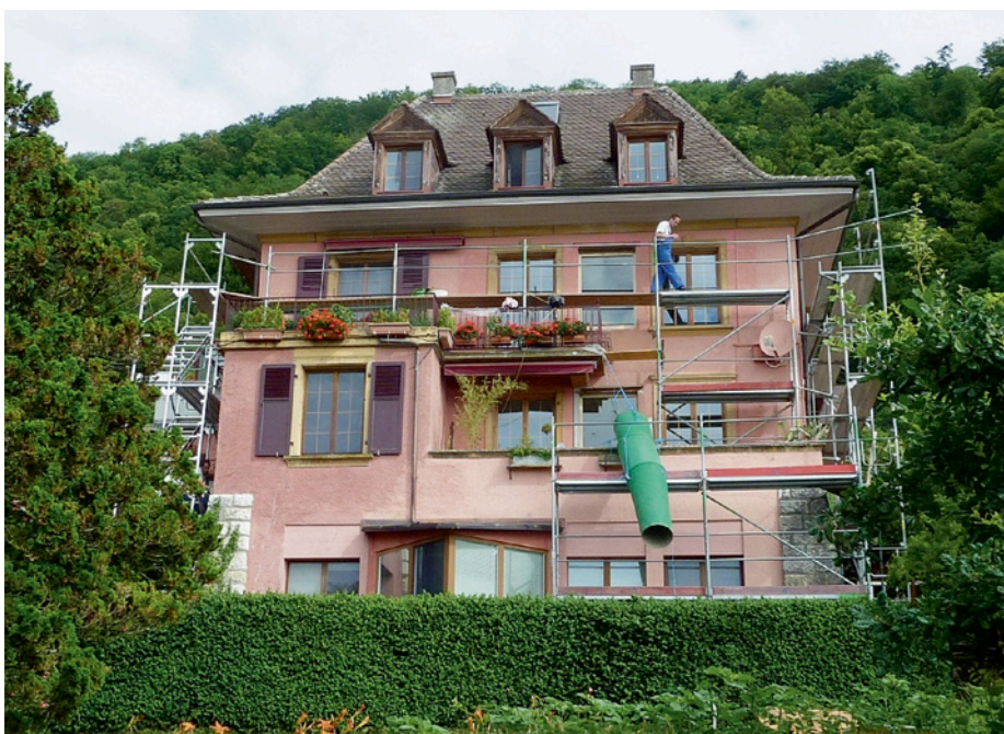
Diese Villa wurde mit einer Aerogel-Kerndämmung energetisch saniert. (Bild: Innodämm)
