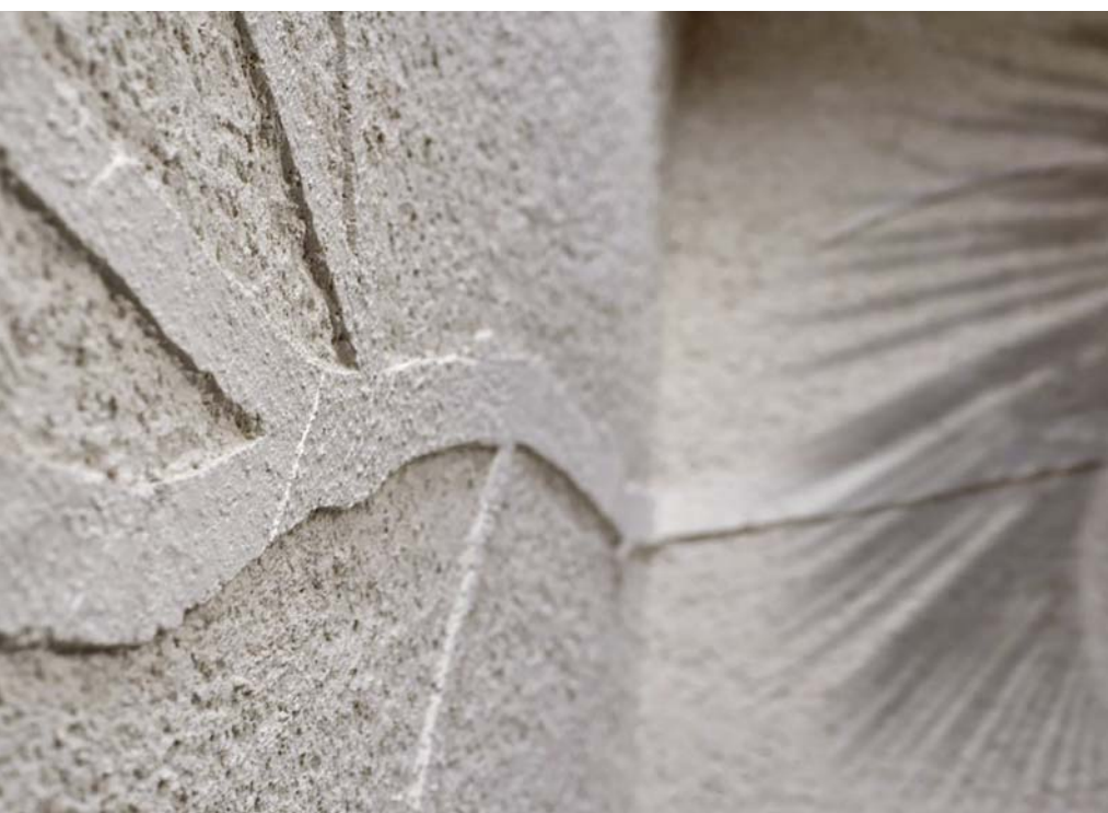
Scharriertechnik im Steinputz auf VAWD, Detail.
