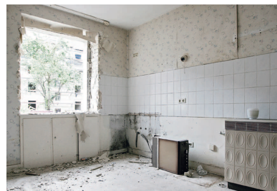
Vorzustand der Räume.
