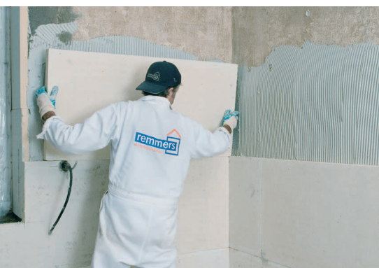
Fixierung der Innendämmplatten im frischen Kleberbett.
