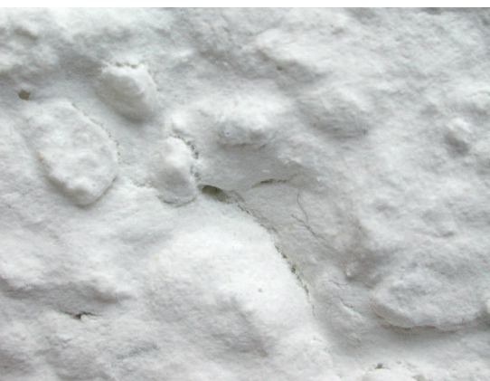
Fenditura in un intonaco di finitura.
