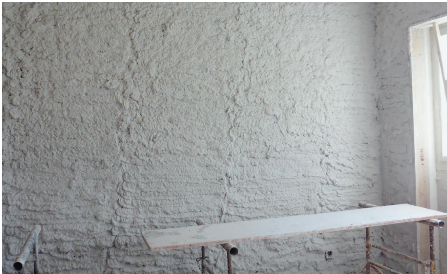
Der Dämmputz, aufgespritzt mit einer Stärke von 6 cm.
