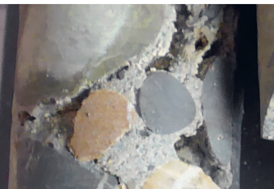
Abb. 3: Bohrkern mit einer nur wenige Millimeter dicken Beschichtung auf einem porösen Mörtel- bzw. Betonuntergrund.
